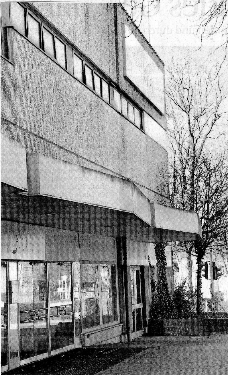
Seit Sommer 2009 vergammelt das Hertie-Kaufhaus. Reparaturen werden nach Schadensfällen nur mit dem geringsten Aufwand ausgeführt.
